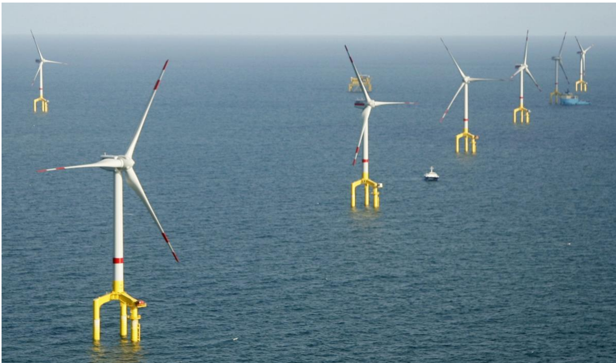
Abbildung 2: Windenergieanlagen Typ BARD 5.0 im Windpark BARD Offshore 1
