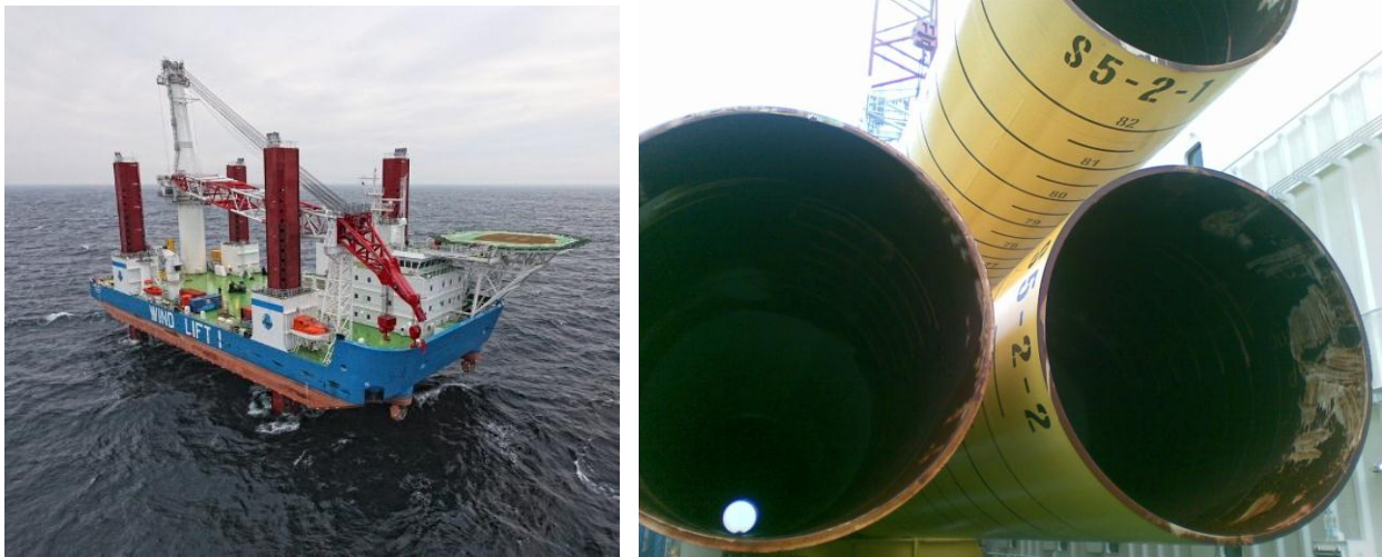
Abbildung 3: Ansicht Pfahlkopfbereich der drei Gründungspfähle einer WEA (rechts) auf der Wind Lift I (links) unmittelbar vor der Rammung
